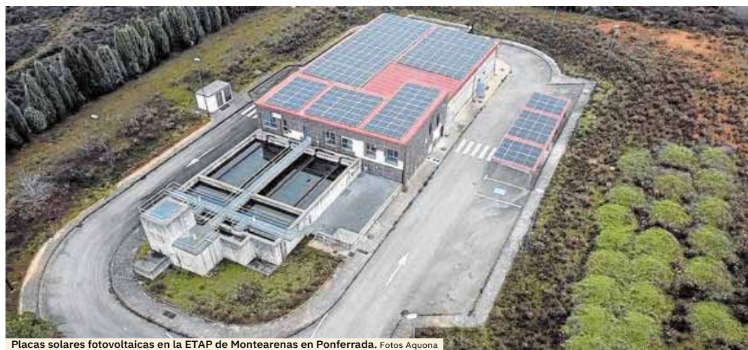
Placas solares fotovoltaicas en la ETAP de Montearenas en Ponferrada. Fotos Aquona
