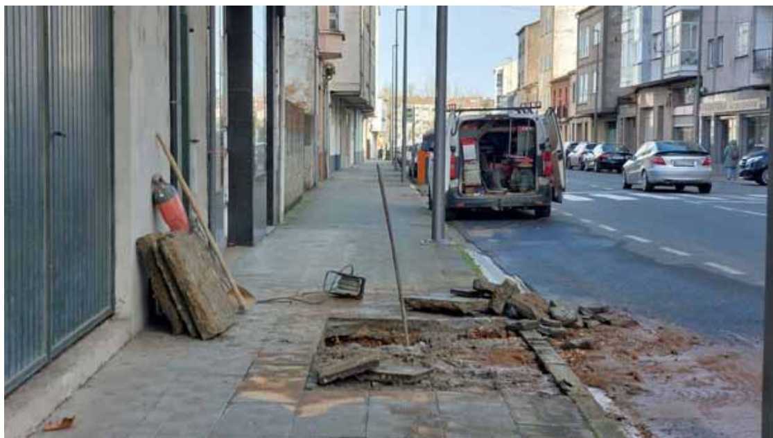
photo_camera Los técnicos de Aqualia levantaron la acera en la Rúa Escultor Francisco Moure para acceder a la tubería. A.R.
