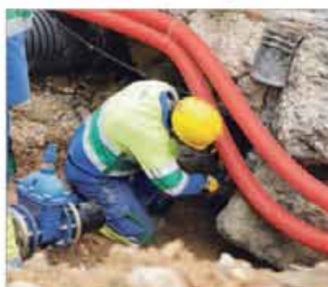
Trabajos en la red de agua. »
