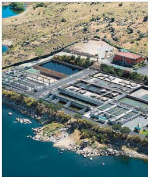
Vista aérea de una depuradora. »
