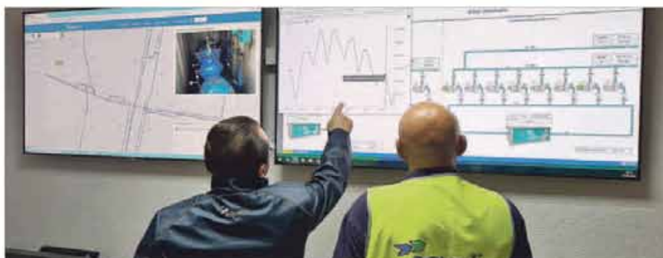
Gracias a la detección temprana de fugas en las redes se evitan pérdidas innecesarias de agua y daños en los sistemas. »
