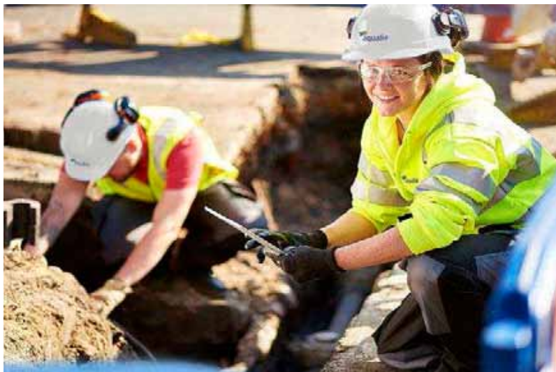
Técnicos de Aqualia trabajan en la red de abastecimiento apoyándose en modelos digitales generados desde el Centro de Operaciones de Toledo.
