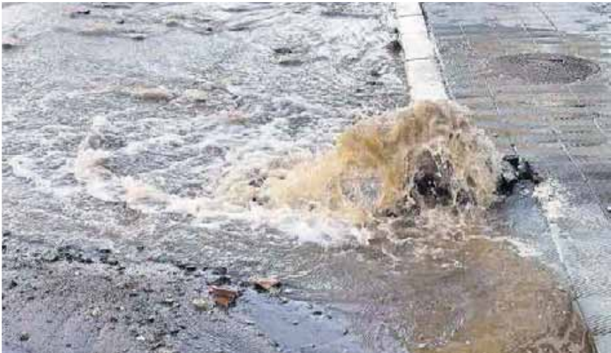
Escape de agua en una calle.
