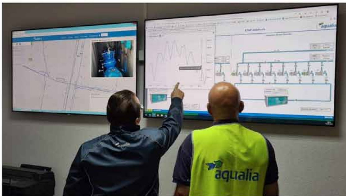
Gracias a la detección temprana de fugas en las redes se evitan pérdidas innecesarias de agua y daños en los sistemas | Aqualia
