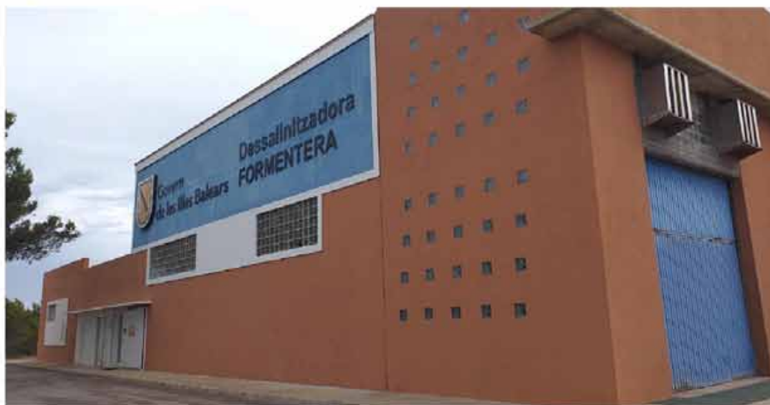
Els interessats podran conèixer in situ tot el procés de recollida i dessalació de l'aigua marina. Arxiu
